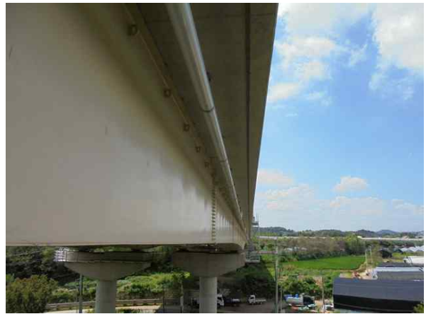
배수관 상태 양호
