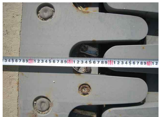
신축이음 이동량 측정
