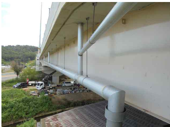
배수관 상태 양호
