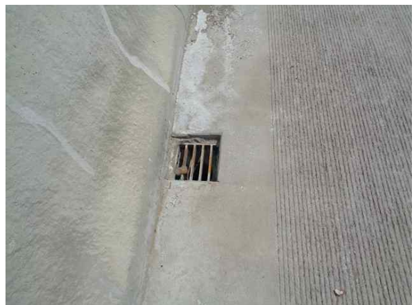
배수구 상태 양호
