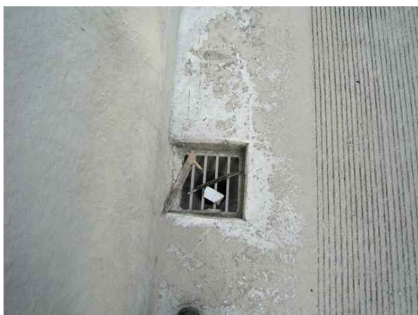
배수구 상태 양호
